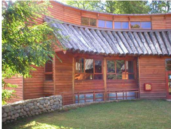
Figura 7: Techo construido de troncos largos y ahuecados, dispuestos uno al lado del otro, denominados 'wuampo'.
