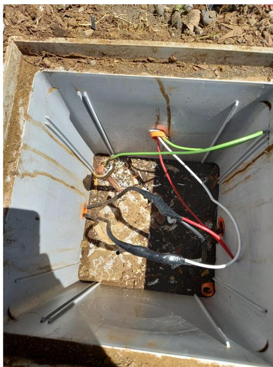
Figura 3: Conexión a red eléctrica
