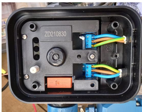
Figura 2: Conexión eléctrica controlador y bomba
