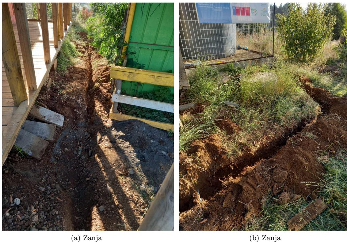
Figura 1: Zanja en la cual se ubicaron los tubos de pvc que llevan el agua y la corriente eléctrica
