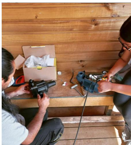
Figura 3: Instalación de bomba periférica
