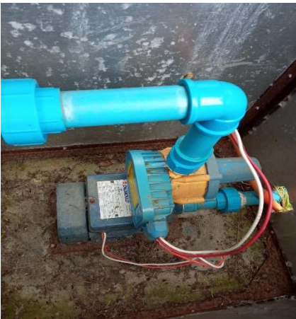
Figura 3. Electrobomba impulsora PKm60
