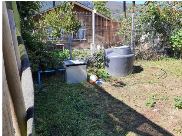
Figura 4. Estanque de 500L conectado al sistema de riego.
